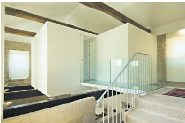
ALFREDO SIRVENT. Rehabilitación en Arbo | MANUEL G. VICENTE
